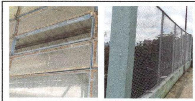
Foto 6: Sustrucción de 26 vidrios en mal estado del modulo 1
